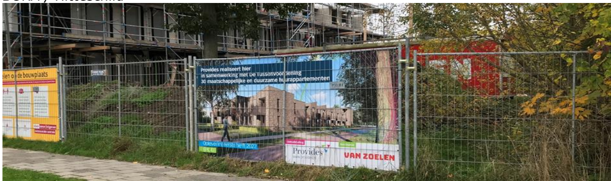
De bouw aan Hitteschild is in volle gang. In mei 2022 worden de woningen opgeleverd.
