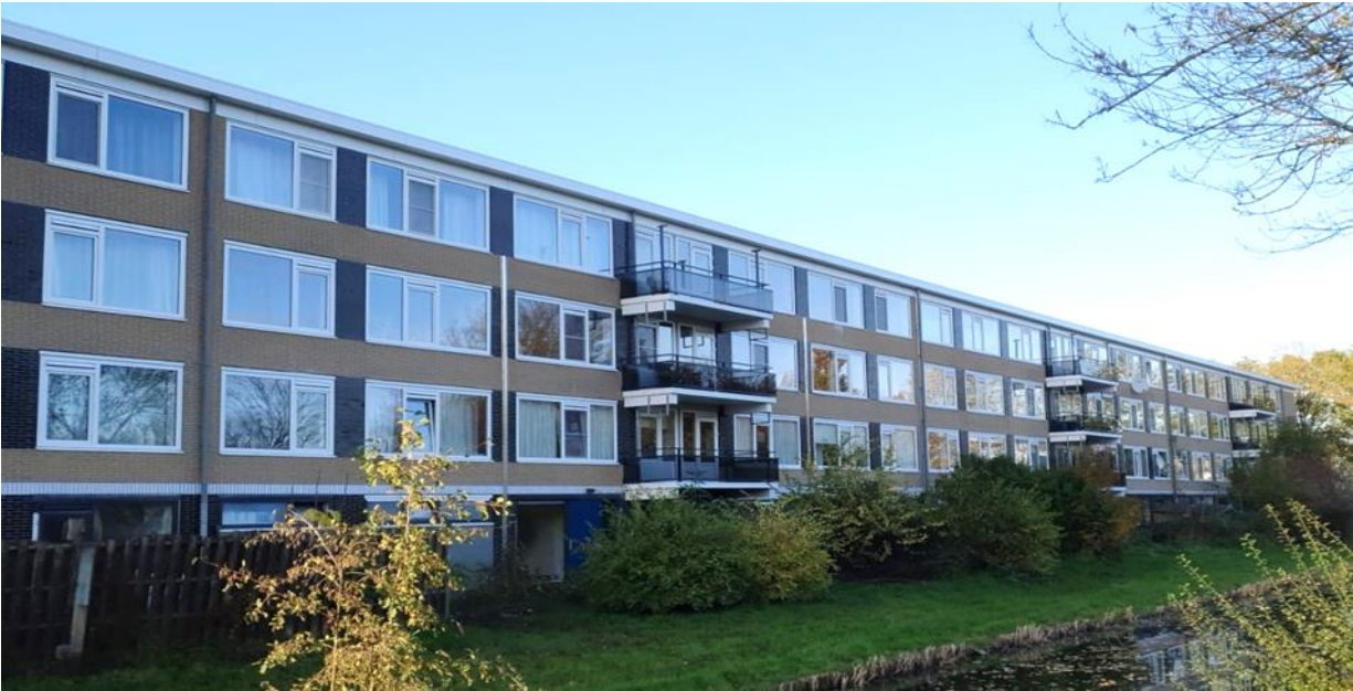
Een van de complexen in IJsselveld-Oost na de renovatie.
